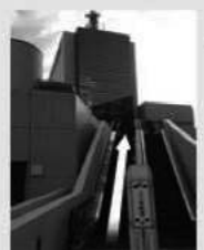
デッキをさらに上がる
